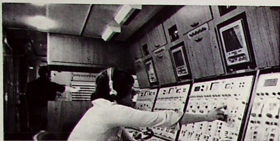
Bild 3. Blick in das Innere des Übertragungs- wagens mit den Über- wachungseinheiten für 25 Kommenta- toren (Foto: ZDF)
